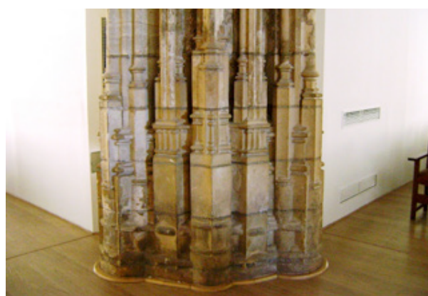
Figura 58: Basas de los pilares del crucero bajo.
