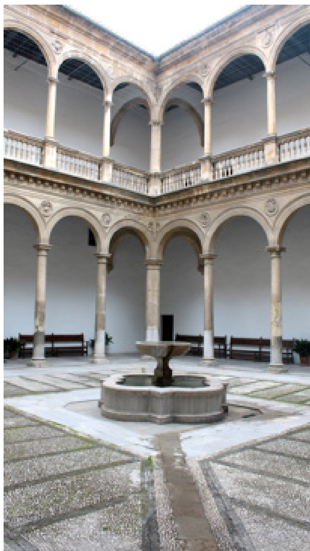
Figura 65: Vista general del Patio de la Capilla.
