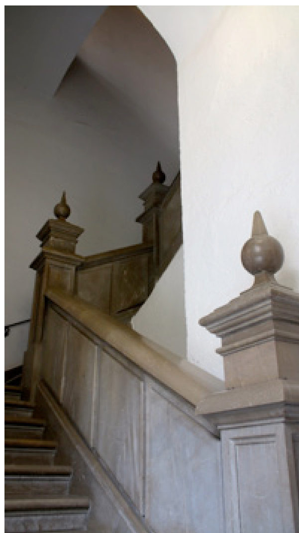
Figura 74: Escalera del patio del Archivo.
