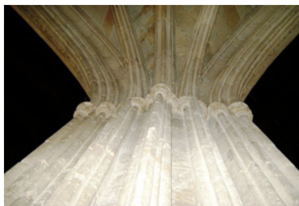
Figura 57: Detalle de las columnillas que recubren los pilares del crucero.
