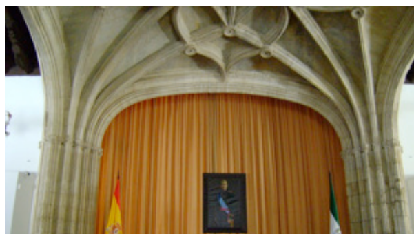
Figura 56: Detalle de los arcos carpanel que forman el crucero bajo.
