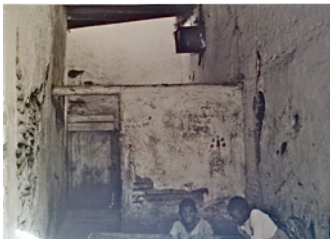
Figura 30: Estado de ruina que presentaban las estancias de los locos.
