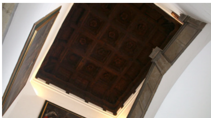
Figura 74 bis: Armadura del patio del Archivo.
