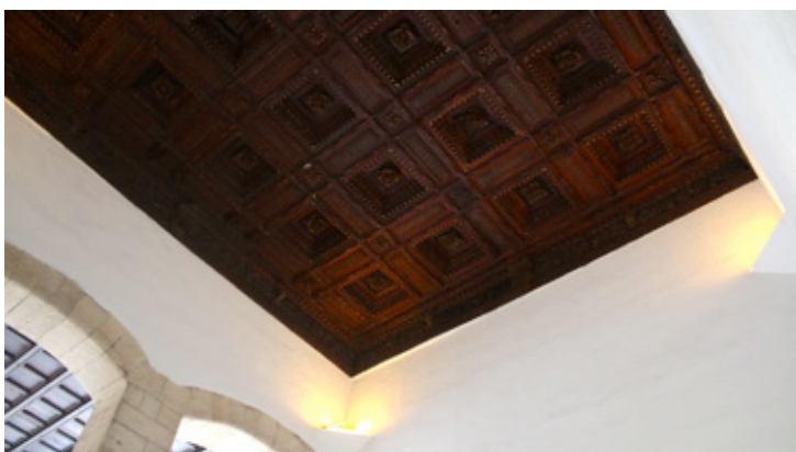
Figura 71: Techumbre de madera de la escalera del patio de los Mármoles.
