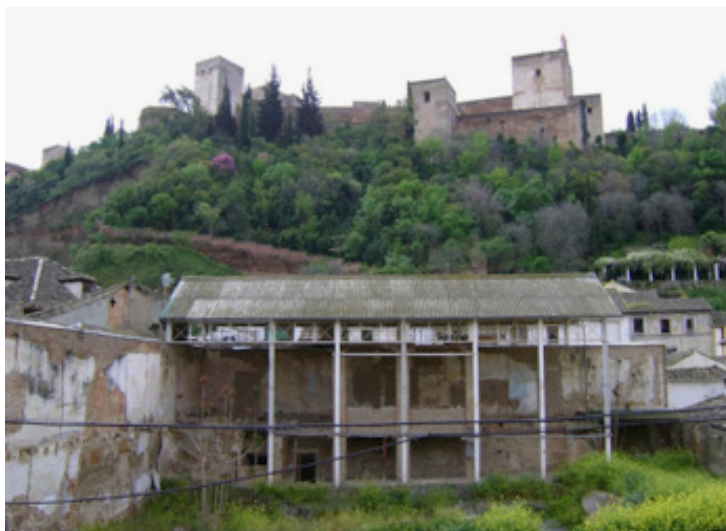
Figura 4: Vista del estado actual del Maristán de Granada
