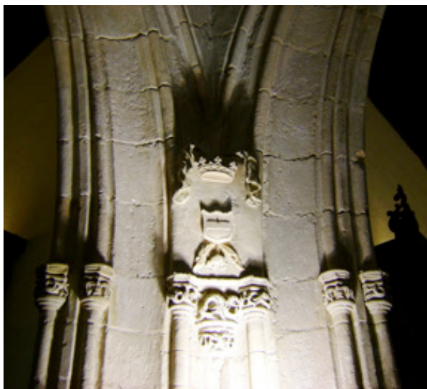
Figura 59: Basas de los pilares del crucero bajo.
